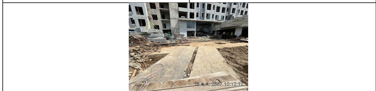
รูปที่ ผ7.27 แผ่นเหล็กอย่างหนาปูทั่วบริเวณภายในพื้นที่โครงการ
