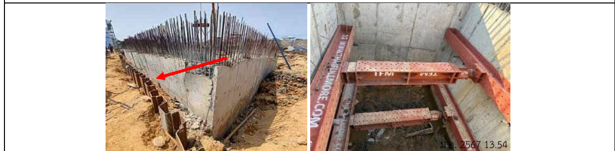
รูปที่ ผ7.24 แนว Sheet Pile และค้ำยัน (Bracing) ในช่วงที่ทำการก่อสร้างระบบบำบัดน้ำเสีย และบ่อหน่วงน้ำใต้ดิน
